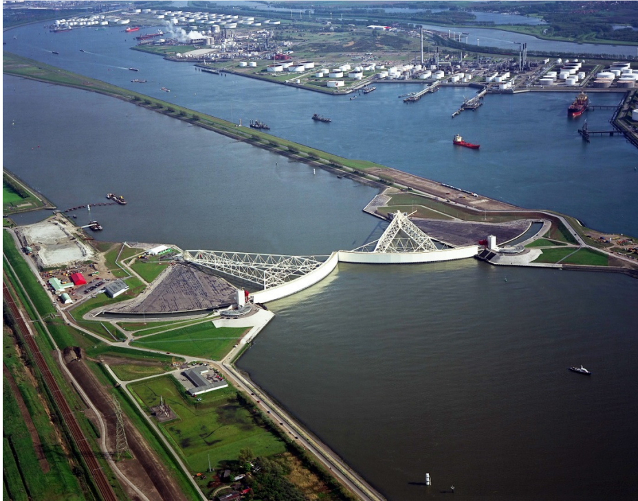
Maeslantkering (Vir: Rijkswaterstaat)
